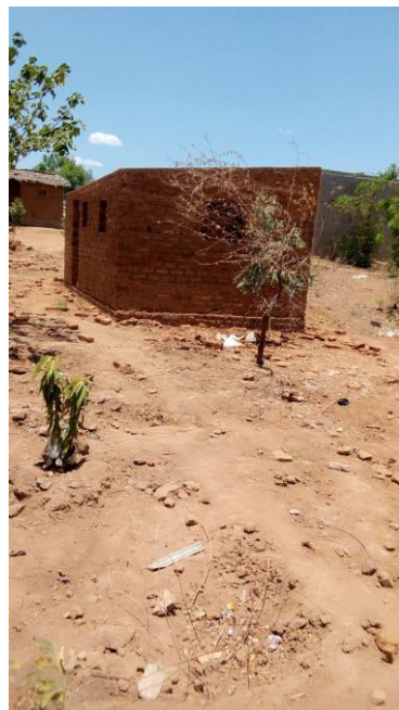
Ett av husen som blivit återuppbyggt
