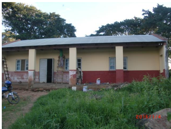
Utvändig målning påbörjad
